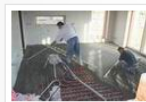
hrubá stavba s čistou podlahou
