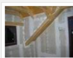
hrubá stavba - příprava na malby
